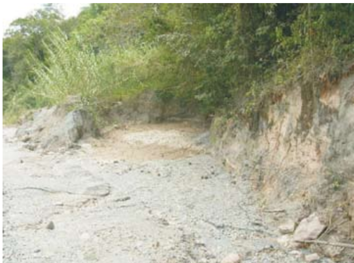
Foto 28. Pequena bacia de decantação nas vias de acesso para uma cava (Foto: Ana C. Neri).
