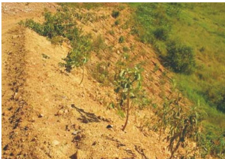
Foto 24. Pilha de estéril em recuperação concomitantemente à sua implantação (Foto: Ana C. Neri).
