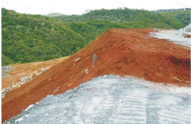
Foto 4. Pilha de estéril recoberta por solo superficial (argila arenosa vermelha) proveniente da ampliação de uma cava, disposto sobre blocos de rocha estéril para posterior plantio de espécies nativas (Foto: Luis E. Sánchez).
