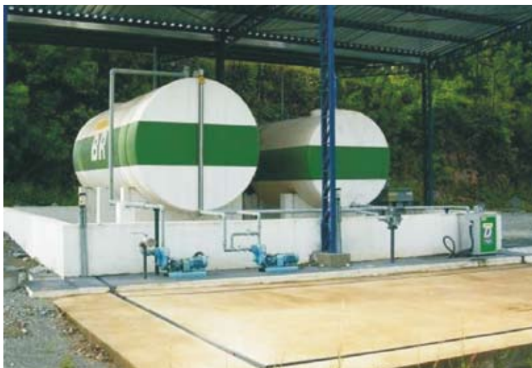
Foto 6. Tanques aéreos recém-instalados. Notar mureta de contenção, cobertura, tubulação aérea, piso impermeável na área adjacente de abastecimento e canaletas para coleta de água (Foto: Ana C. Neri).
