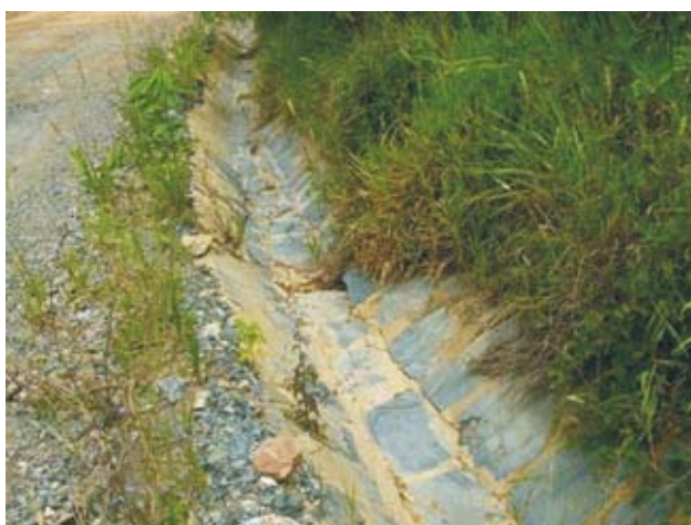
Foto 14. Detalhe das canaletas revestidas por dolomito (Foto: Ana C. Neri).
