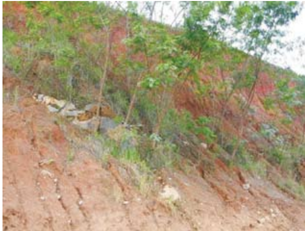
Foto 18. Talude com cobertura vegetal temporária, em área reservada para futura expansão da mina (Foto: Ana C. Neri).
