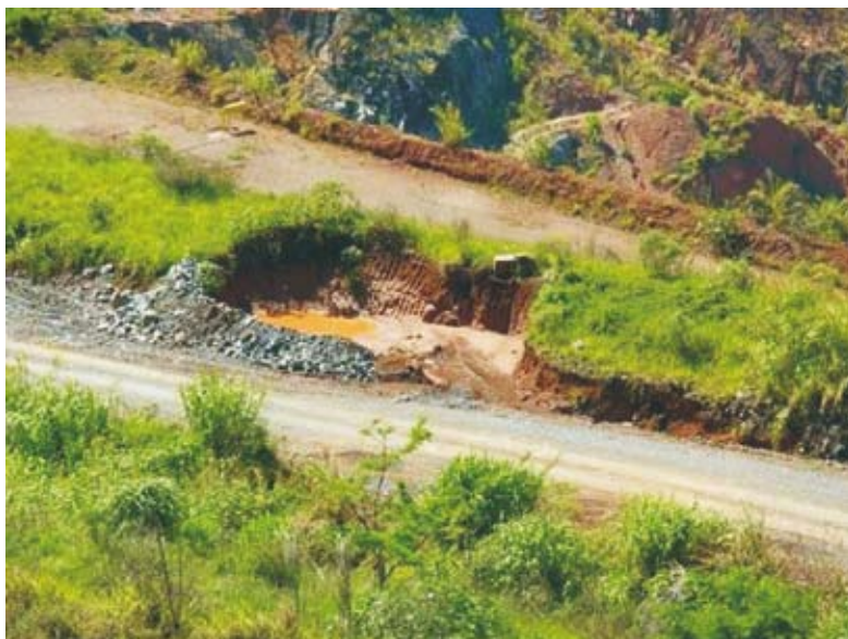
Foto 12. Canaleta escavada in situ , associada a bolsões de sedimentação distribuídos nas vias de acesso visando reter sedimentos provenientes de duas pilhas de estéril (Foto: Ana C. Neri).
