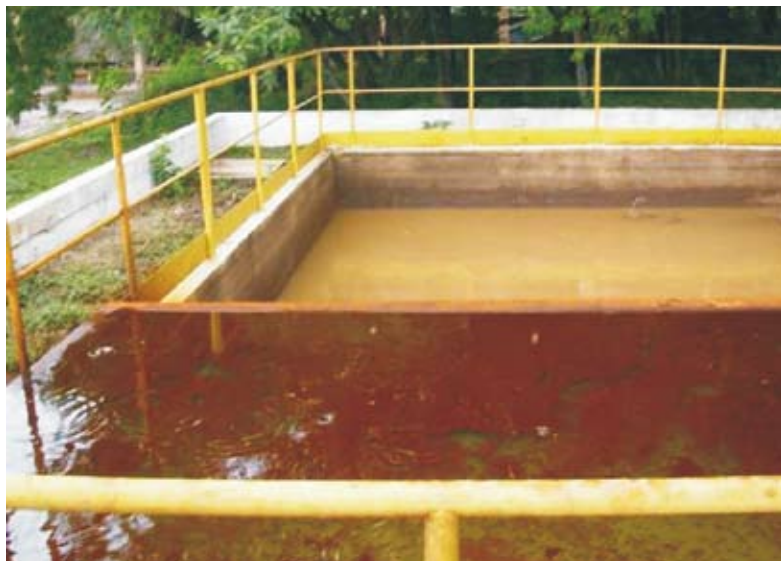
Foto 36. Bacias de separação de óleo e água (Foto: Ana C. Neri).
