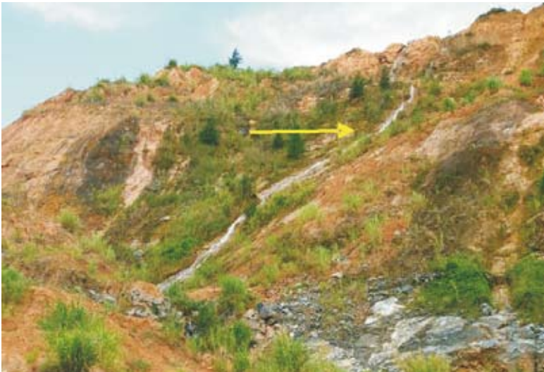
Foto 45. Água pluvial fluindo sobre talude sem proteção, devido à obstrução de canaletas perimetrais (Foto: Ana C. Neri).
