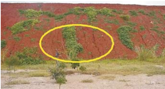
Foto 44. Recuperação dos taludes por semeadura “a lanço” em uma pilha de estéril. Notar, em detalhe, plantio de leguminosas que apresentam rápido crescimento e incorporam nitrogênio ao solo (Foto: Ana C. Neri).
