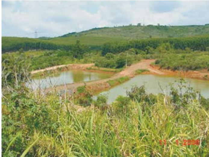
Foto 27. Bacias de decantação escavadas localizada a jusante de uma cava que recebem sedimentos carreados pelas águas pluvias de todo o entorno de uma mina, incluindo as vias de acesso (Foto: Ana C. Neri).
