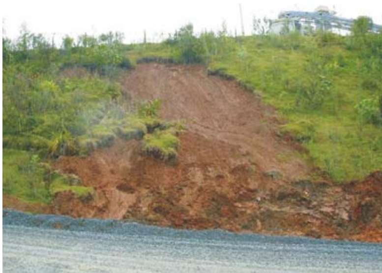
Foto 10. Escorregamento de solo em talude de corte em via interna de circulação de mina (em primeiro plano), causado por ausência de sistema de drenagem (Foto: Ana C. Neri).
