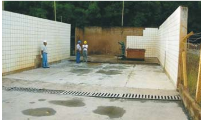
Foto 8. Área de lavagem dotada de piso impermeável e sistema de drenagem para a condução de efluentes às caixas separadoras (Foto: Luis E. Sánchez).
