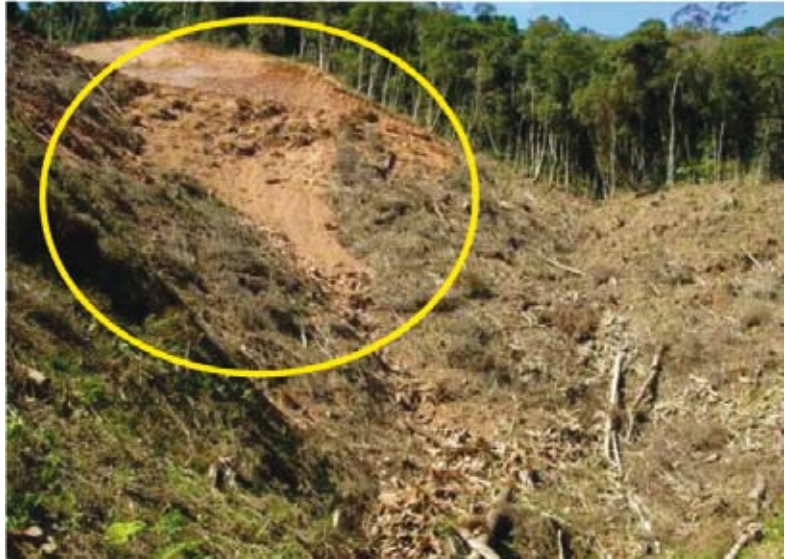
Foto 2. Área preparada para remoção de solo superficial após a retirada da vegetação. Em detalhe, porção onde o solo superficial já foi retirado em terreno de alta declividade (Foto: Ana C. Neri).
