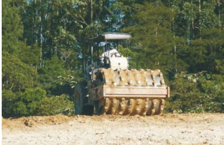
Foto 20. Compactação de pilha de estéril construída pelo método ascendente em uma pedreira de granito (Foto: Luis E. Sánchez).
