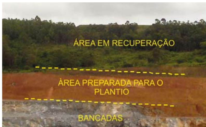
Foto 17. Vista das bancadas de uma mina. Notar ao fundo, uma área em vias de recuperação, já dotadas de vegetação; na porção central, uma faixa preparada para plantio (com solo exposto) e em primeiro plano, bancadas em rocha (Foto: Ana C. Neri).
