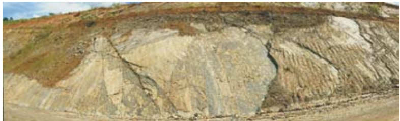
Foto 16. Taludes em rocha são em conformação final no setor superior de uma cava. Nota-se que o ângulo do talude está adequado com o ângulo de mergulho da rocha favorecendo a sua estabilidade (Foto: Ana C. Neri).
