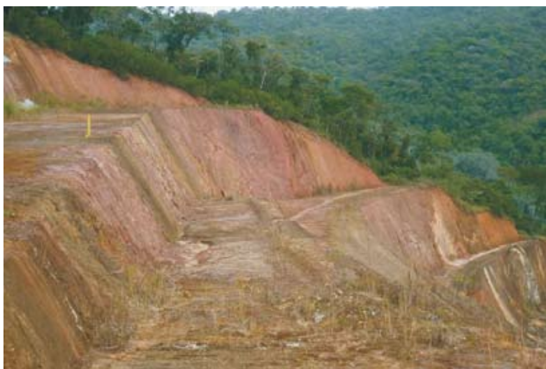
Foto 37. Retirada de vegetação estritamente necessária para avanço de área de decapeamento em uma mina de calcário (Foto Luis E. Sánchez).
